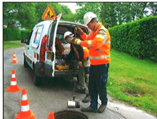
Pour vérifier l'état des réseaux d'assainissement, le système Diagrap, rapide et performant, est utilisé par la Lyonnaise des eaux.
